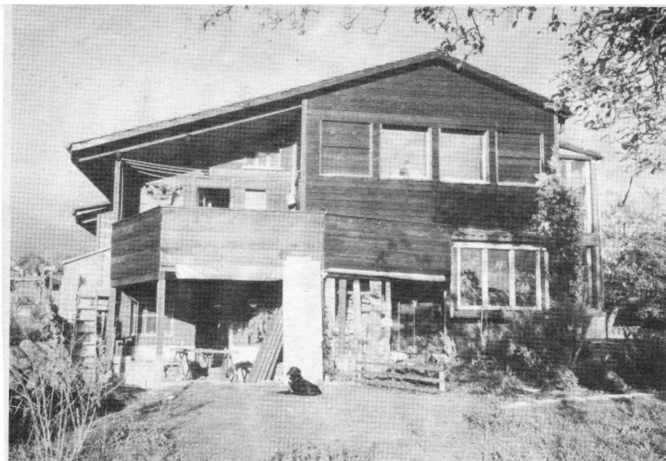
Hochwald, Baselweg, Südwestfassade gegen das Dorf zu.
